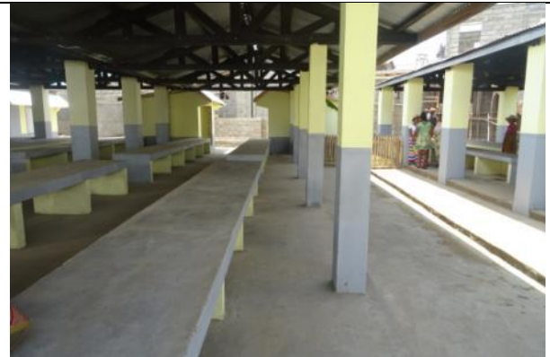
Sol bétonné et rigoles d'écoulement des eaux
