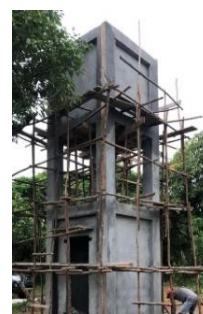
Château d'eau en cours
